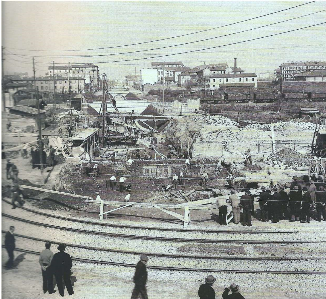
I lavori di copertura dell'Olona nella circoscrizione esterna
